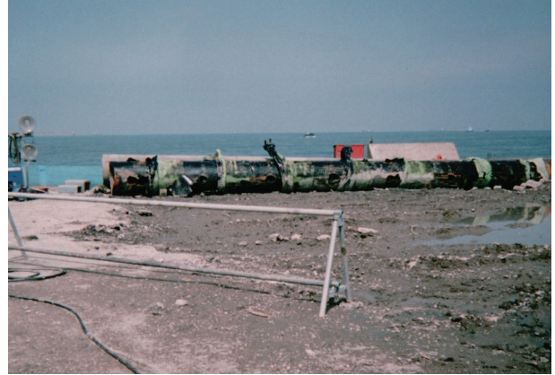
NF 鋼管杭 φ806 L=76m 引抜き (川崎市浮島)
