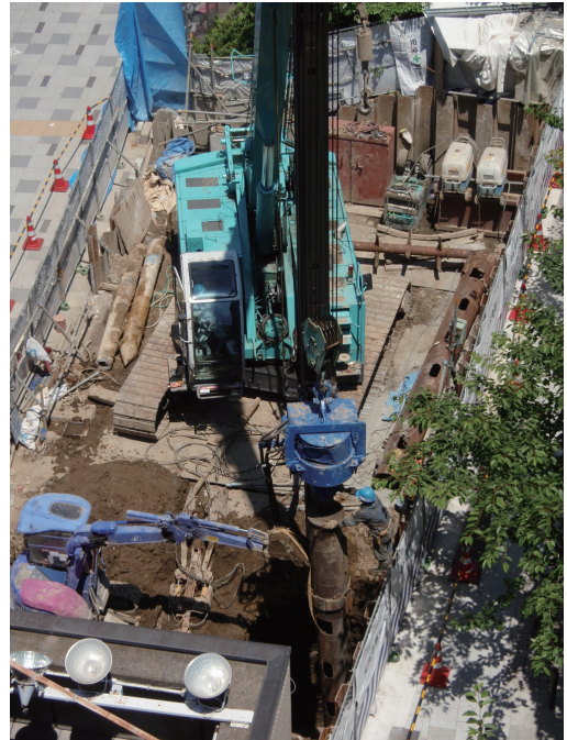
狭小敷地杭引抜き施工状況 (千代田区永田町)
