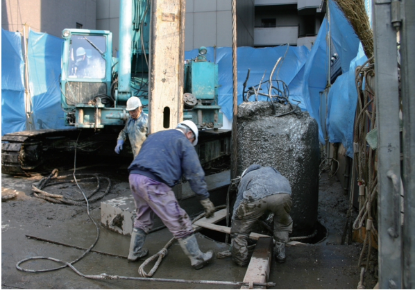
耐震強度偽装物件の既存杭引抜き状況 (東京都港区芝浦)
