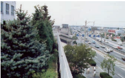
屋上庭園排水
