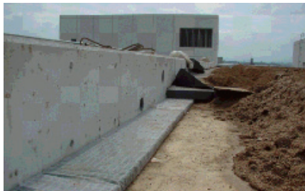
下水処理場屋上体育施設暗渠排水
