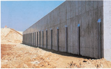
道路擁壁裏面排水（全透水型）
