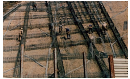
吹付法枠裏面排水（丸形ヘチマロン）
