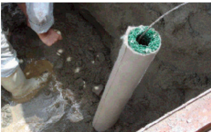
軟弱地盤の液状化の防止対策
