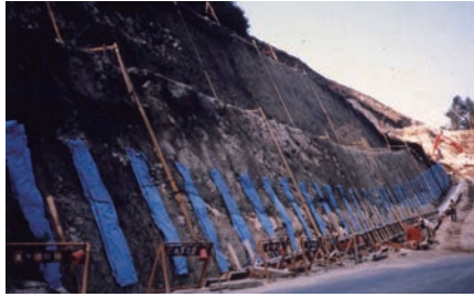
もたれ擁壁裏面排水（半透水型）
