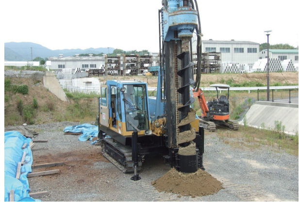
スーパーロックEX \alpha 掘削状況(完全乾式)
