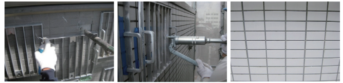
④注入孔穿孔・孔内の清掃 ⑤注入ピンニング ⑥押さえ金具の取り外し・仕上げ・養生・清掃
