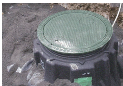
③配管後、土の埋め戻し
