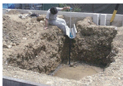
①土の掘削
