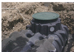
②タンク設置
