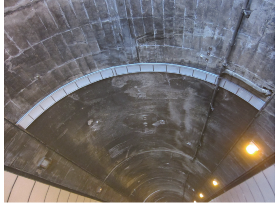
アーチ・ドレン施工現場 (管子トンネル)
