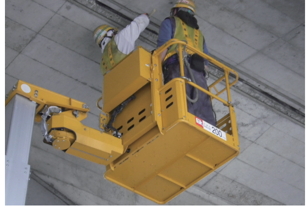
高架橋施工例
