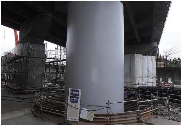
大谷川橋 (静岡県)
