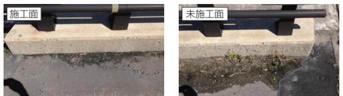
エクセルバリアを施工した地覆（左写真）はコンクリート表面の損傷が小さく、未施工の地覆（右写真）では、スケーリングなどにより表面が損傷していることが確認できる。
