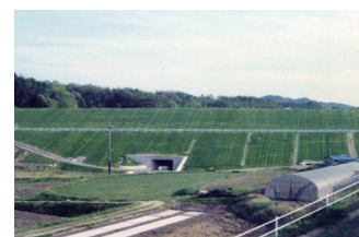
植生後の法面
