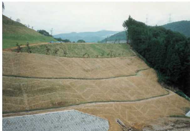
本工法により施工後の法面
