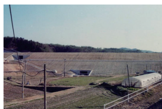
施工直後の法面
