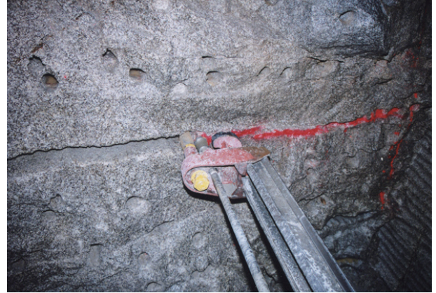
連続孔穿孔状況
