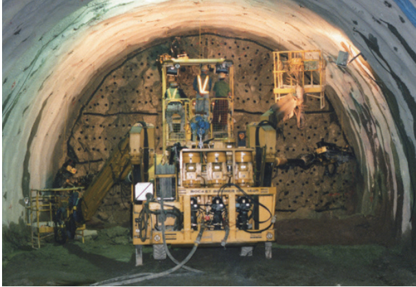
トンネル内での施工状況
