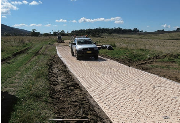
仮設道路の使用例
