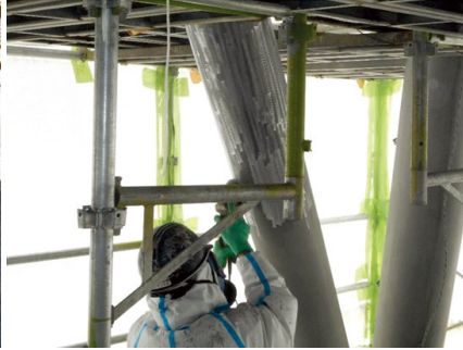
モイストップK工法による作業風景
