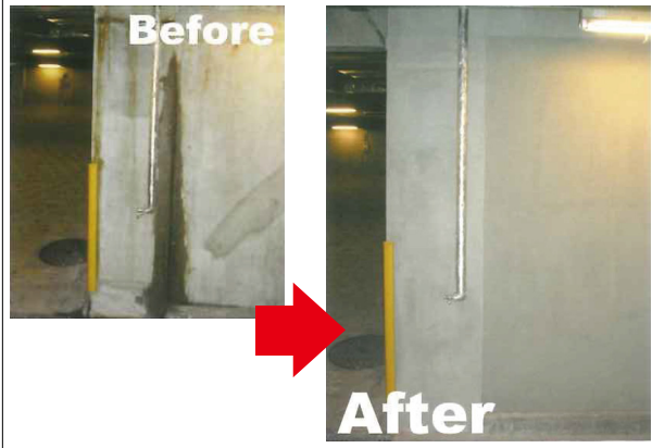
施工前・施工後
