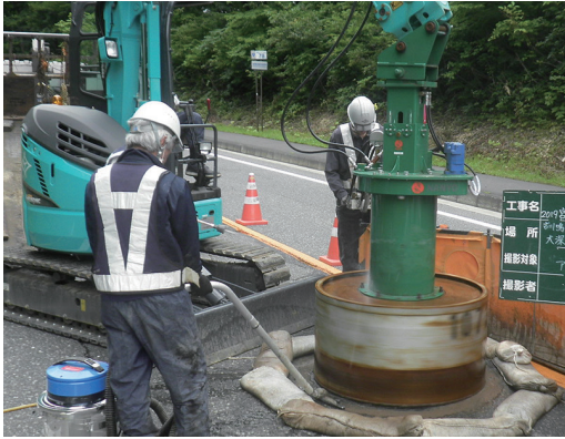
バックホウ搭載円形カッター装置 カッター径φ650~1,630mm
