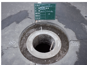
④ 撤去完了組立作業
