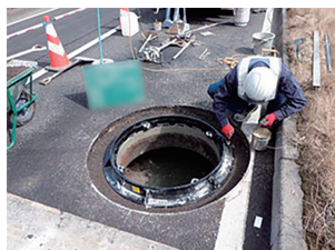
⑤ 新しい鉄蓋の設置
