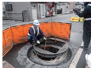
③ マンホール鉄蓋撤去
