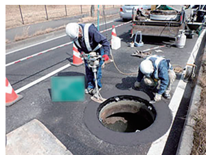
⑥ 樹脂コンクリート材料復旧
