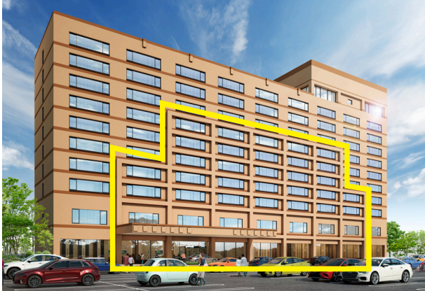
施工例（黄色の囲み部分が施工箇所）
