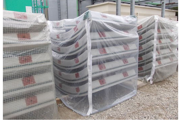
「マク助」によるシールドセグメントの養生状況
