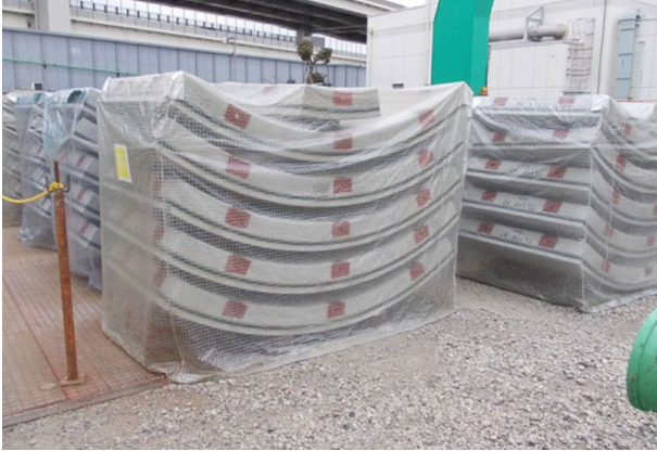
「マク助」によるシールドセグメントの養生状況
