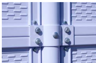
主柱中段継手 (二段張り用)
