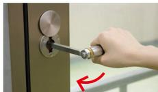
②ハンドルを回すと枠に扉が圧着され止水完了
