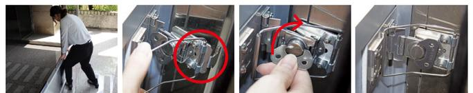
①止水ゴムと柱を密着させる ②ブラケットを柱に引っ掛ける ③つまみを回す ④ロックを下げて完了
