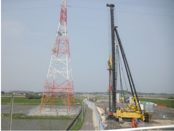
高圧線鉄塔に近接した施工事例
