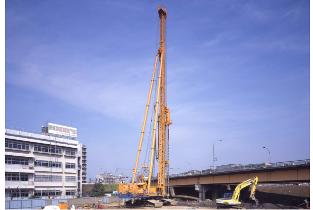
道路橋及び学校施設に近接した施工事例
