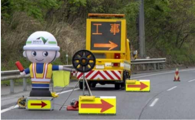
i光太郎くん工事規制設置状況
