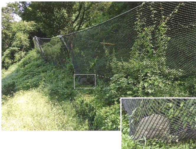
写真 落石捕捉時
