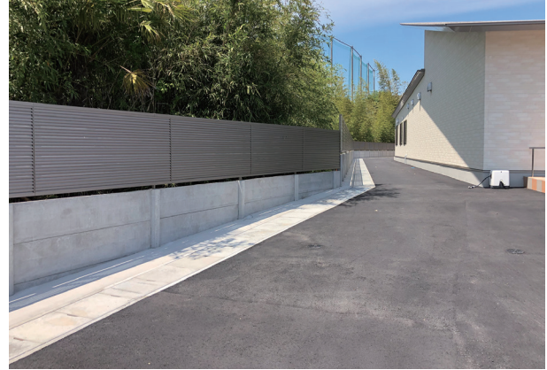
施工例（竹の根対策）
