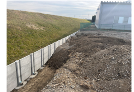
土留めの施工例
