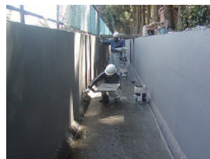
⑤モルタル塗り工
