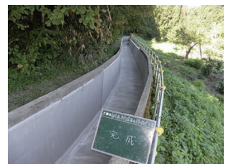
⑥養生・完了
