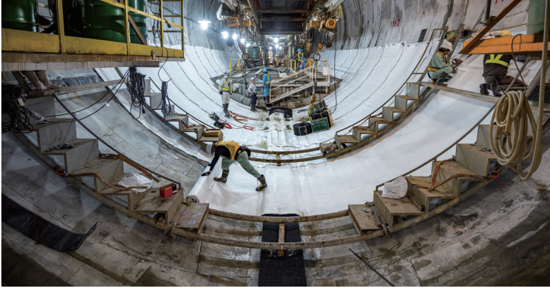
化学接着性防水シート〈フィットライナー®〉の施工風景
