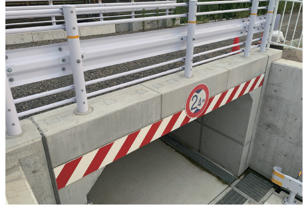
アンダーパスとして施工したボックスカルバートへの設置例
