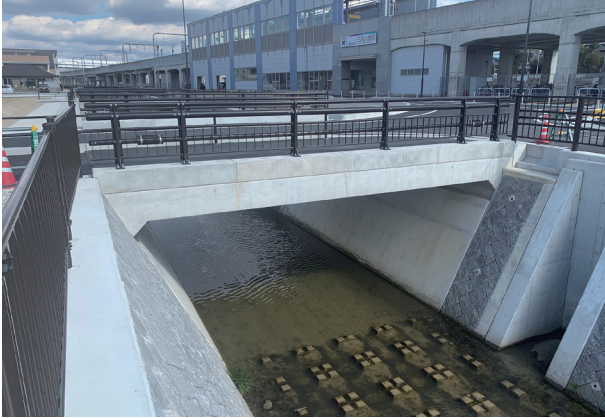
橋梁として施工したボックスカルバートへの設置例
