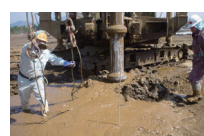
杭工事より発生する汚泥
