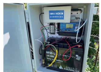
④水位計を設置しLTE-M通信機に接続する
