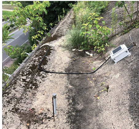
グラウンドアンカー荷重計観測状況
