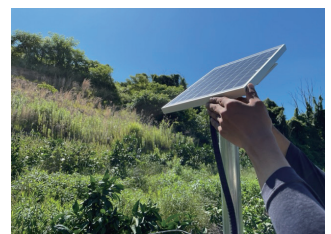
②ソーラーパネルを設置する
