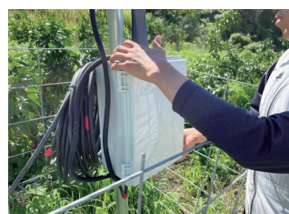
③アンテナ・LTE-M通信装置を設置する
