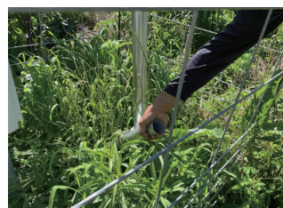
①単管パイプを設置する
