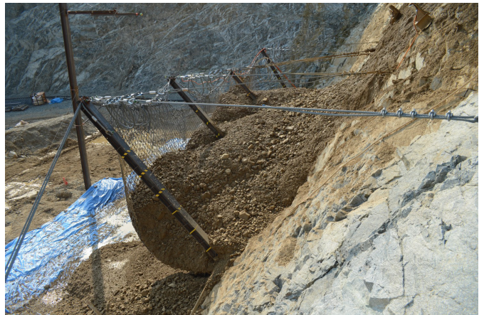
崩落土砂捕捉の実証実験の様子
