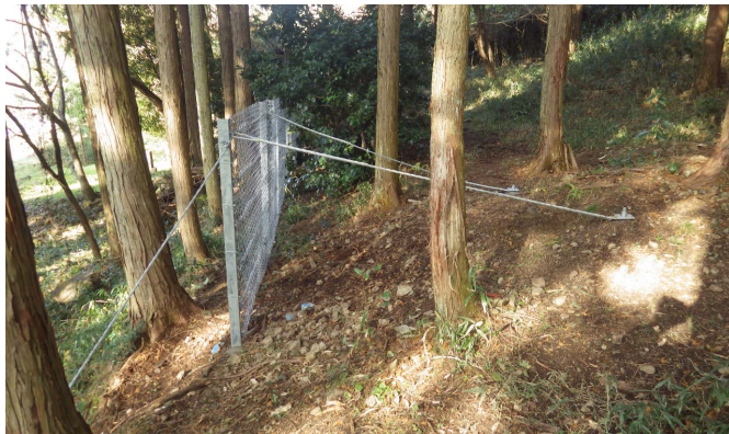
立木を伐採せずに施工できる
