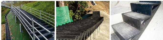
切土斜行面設置
