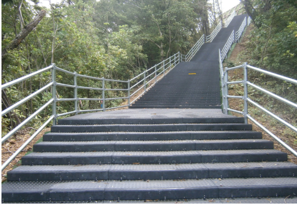
防災対策・避難用階段
