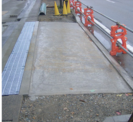
コンクリート打設完了
