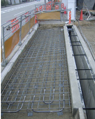
融雪パイプ敷設
