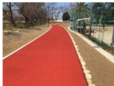
施工事例（公園内遊歩道）
