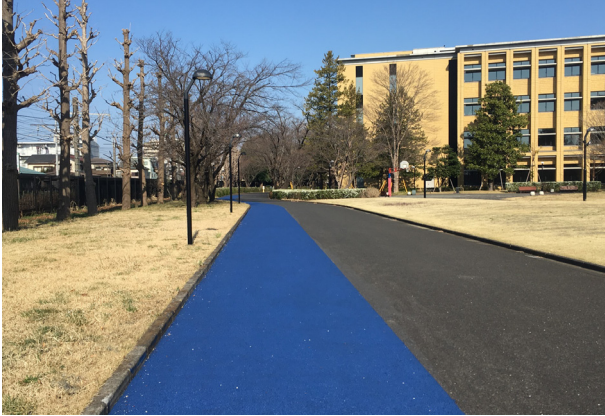
施工事例（教育施設）
