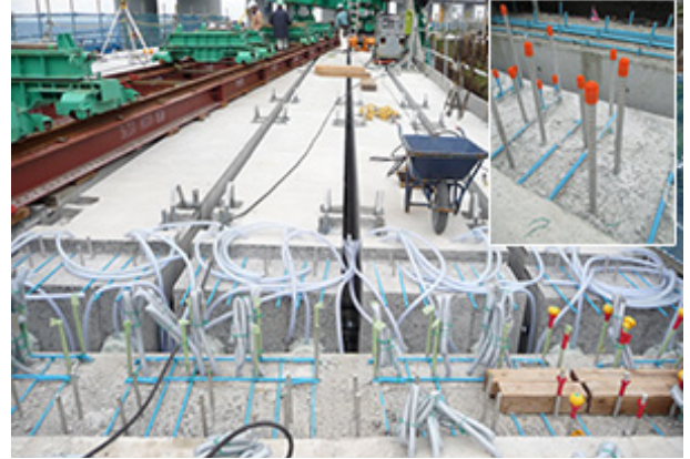
高架橋 伸縮装置乗継部
