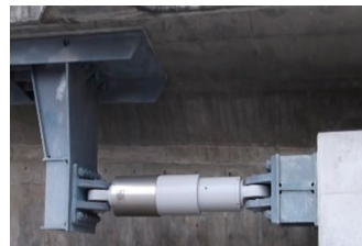
コンクリート橋
