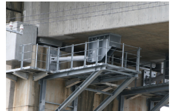
コンクリート鉄道橋
