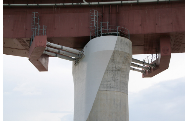
鋼橋 耐震補強実績写真
