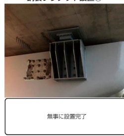
鋼製ブラケット設置④
