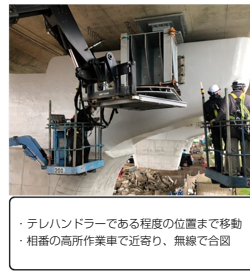
鋼製ブラケット設置④
