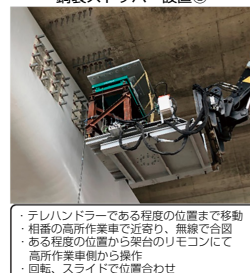
鋼製ストッパー設置④
