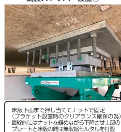
鋼製ストッパー設置④
