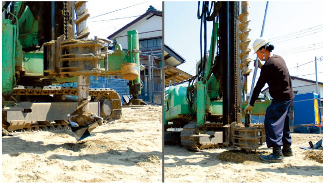
先端翼と細径鋼管の挿入
