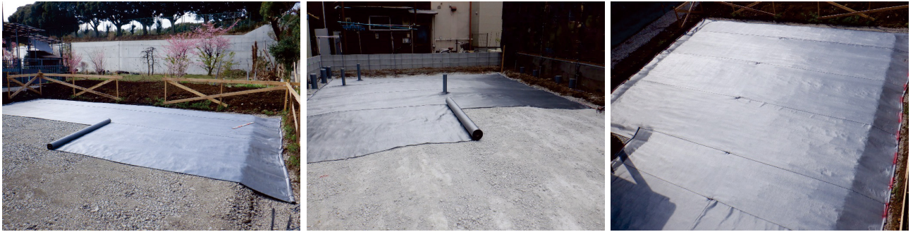
専用的高張カクロスを用いたジオクロス®・ユビファ®工法の施工例
