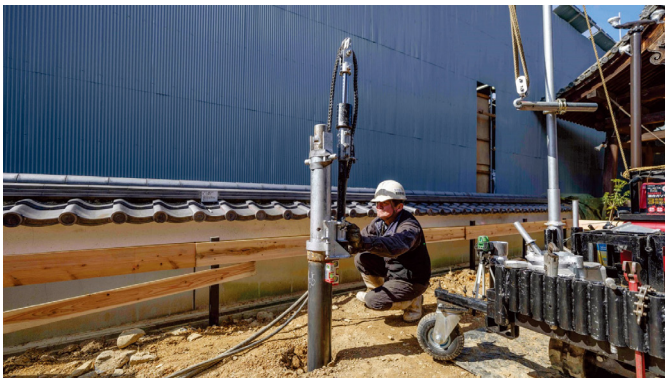
文化財改修工事
