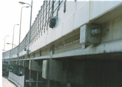
曽根高架橋 外ケーブル補強工法の横定着ブロック横締め
