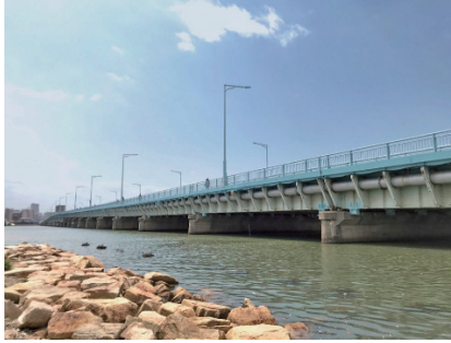
国道2号淀川大橋 (床版取替他工事後)
