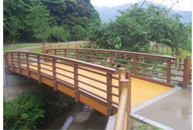
施工例 緊急車両3t通行可
