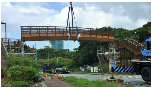
一括架設状況 (橋長18.5m、6.5t) 110tクレーンによる架設
