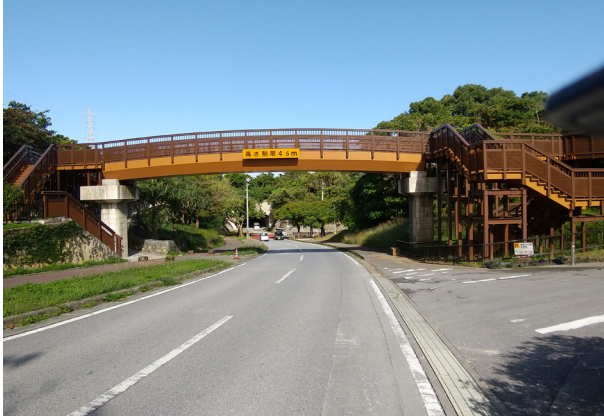
施工例 (浦添大公園連絡橋)
