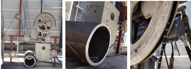
ワイヤーソーイング工法
