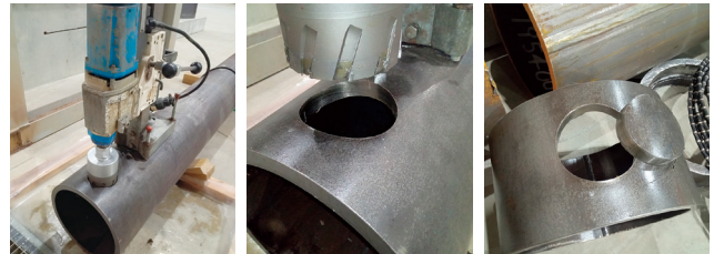
コアドリリング工法
