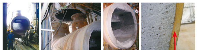
耐火材と金属を同時に切断
