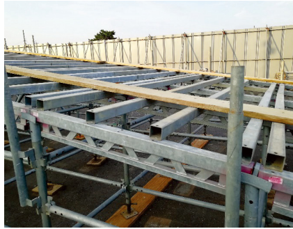
PC構台仮設斜路工法
