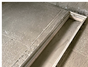
④ピット内防水仕上げ
