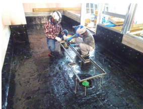
①受枠設置・レベル調整
