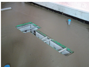
③コンクリート打設
