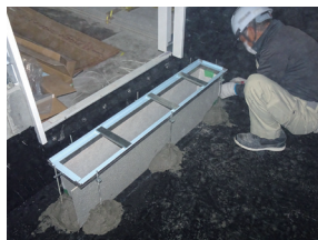
②ボード取付け・モルタル固定
