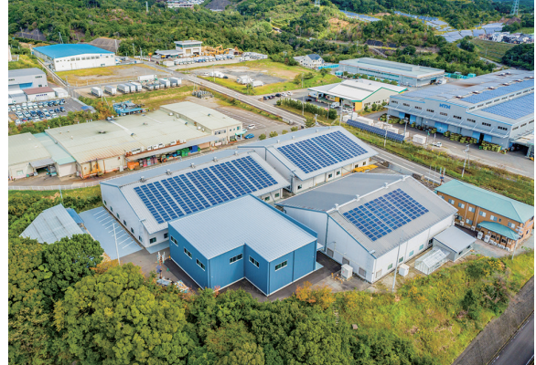
和歌山工場全景
