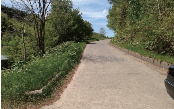
水路と農道を兼ねた道路の施工例 (1975年施工で現在も問題なく使用されている)
