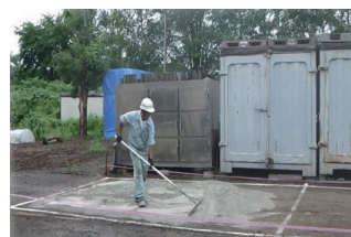
①STEIN敷き均し
