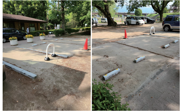
公園駐車場の施工例 (周辺の自然との調和が考慮されている)
