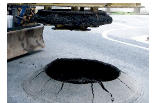
④マンホールフレーム撤去
