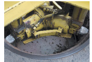
②舗装切断
