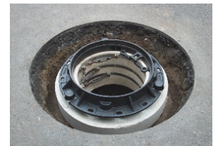
⑥マンホールフレーム設置
