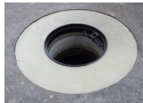
⑦MR 2 モルタル打設
