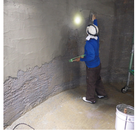
ZモルタルS-1塗布状況
