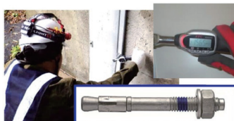
ウェッジ式締付方式金属系アンカー
